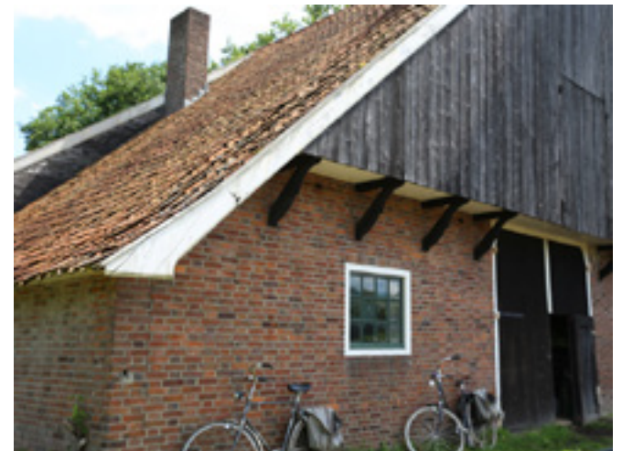
Detail van de topgevel en windveer
