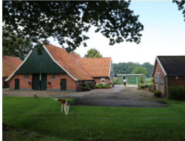
Bestaand erf met boerderij en schuur
